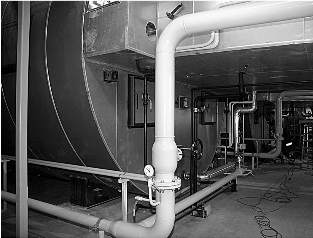
Срок сдачи котельной в эксплуатацию - 14 февраля 2011 года, но уже с 1 января она будет способна обеспечивать потребителей теплом.
