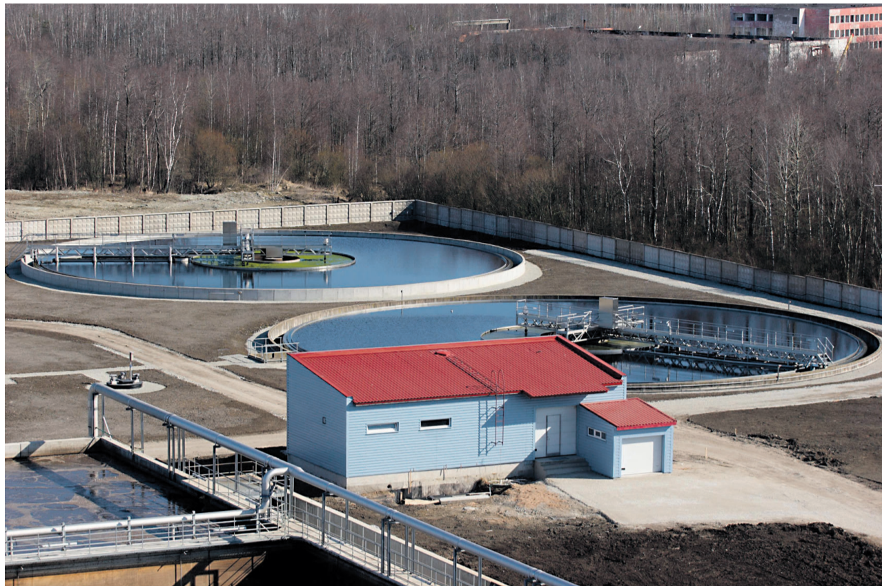
Kohtla-Järve regionaalsed reovee puhastusseadmed, valminud 2009
